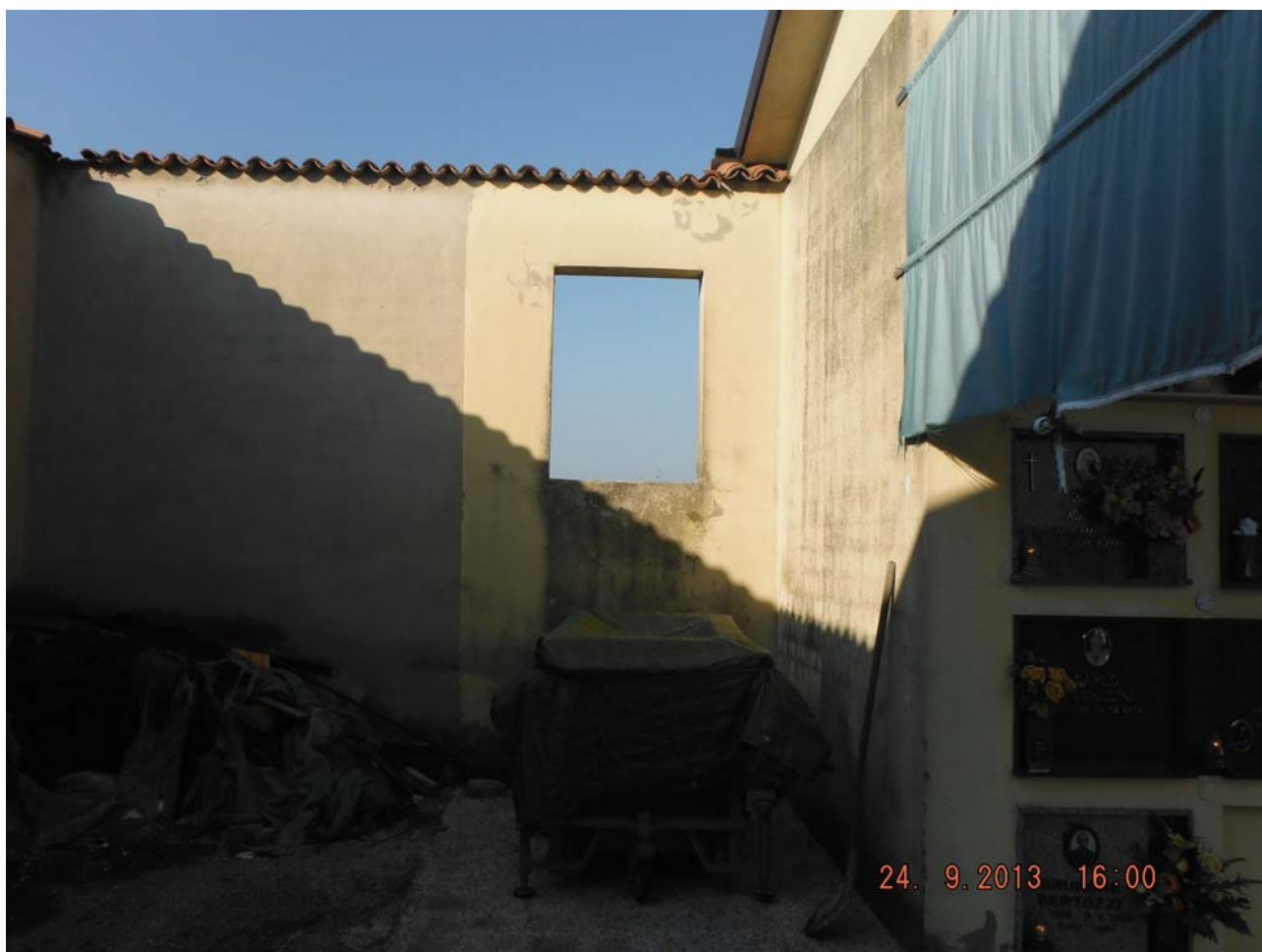
Foto n. 7 : Zona di intervento e vista del collegamento con l'area di cantiere e stoccaggio materiali ottenuta demolendo la porzione di muratura sotto la finestra.
